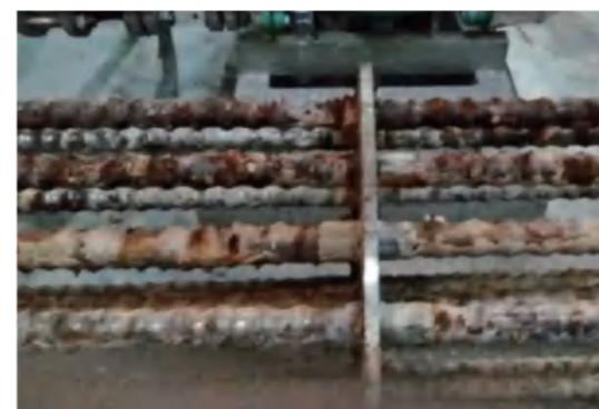
未安装前，表面垢下腐蚀严重，造成穿孔
