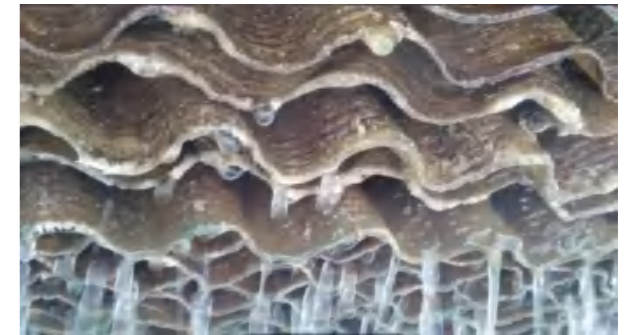
安装4个月后，冷却塔内垢和藻类逐渐减少至微量
